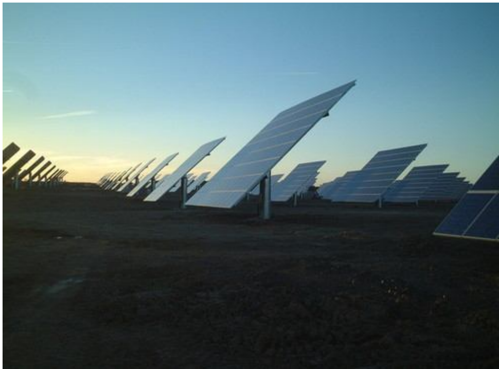
Illustrazione 7 - Esempio di centrale fotovoltaica
